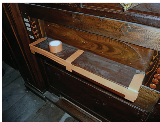
Protection de l'orgue et de son clavier pendant les travaux de restauration (photographies 2011, collection « Amis des orgues »)
