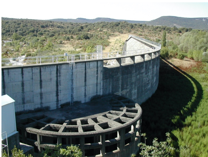
Barrage de Ceyrac amont (Photo F. Obert)
