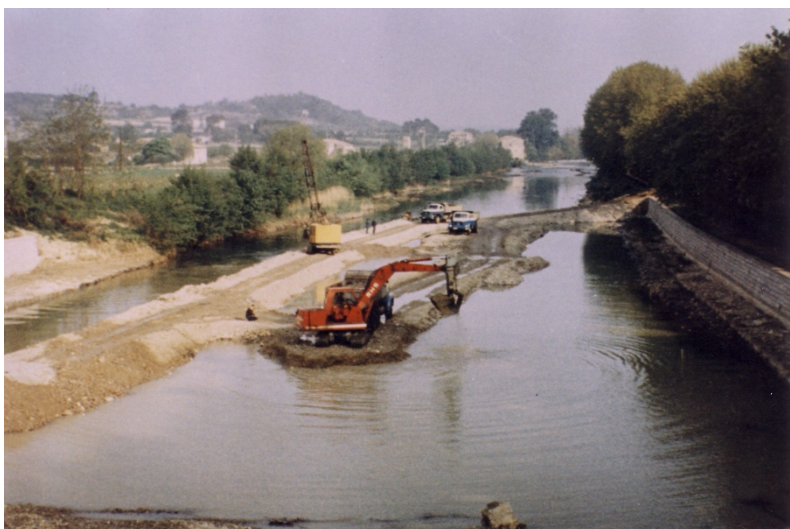
Travaux de curage – 1968 (Photo G. Vidal)
