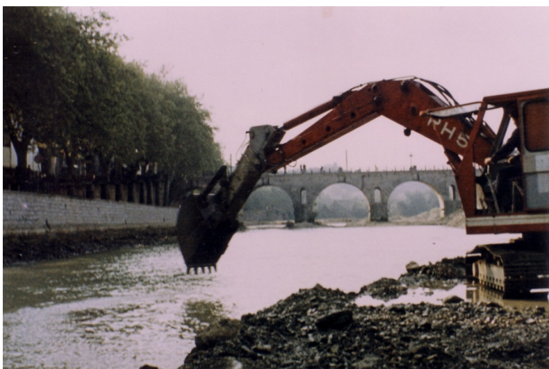
Travaux de curage – 1968 (Photo G. Vidal)
