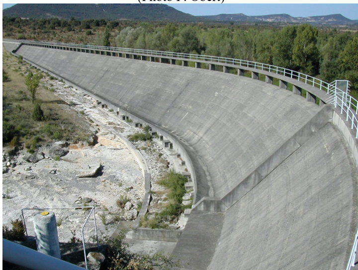
Barrage de Ceyrac aval (Photo F. Obert)
