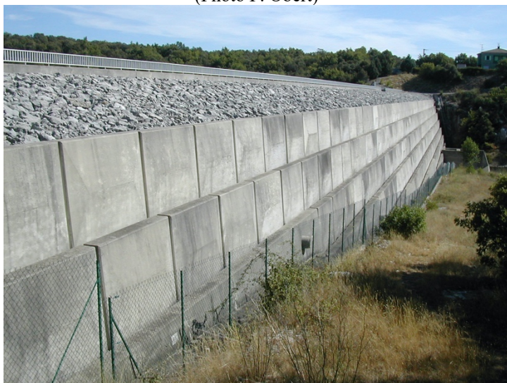
Barrage de Conqueyrac aval (Photo F. Obert)
