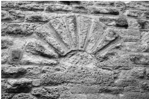
Fig.7 : ancienne porte au S. de la tour Bermond avec tympan sur linteau et sous arc de décharge
