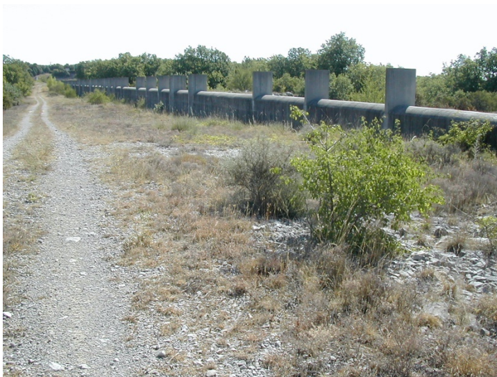
Barrage de Conqueyrac amont (Photo F. Obert)
