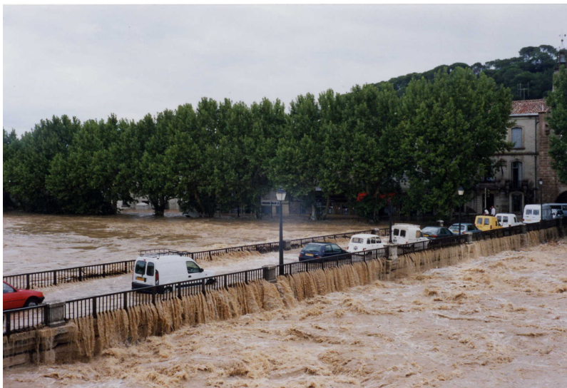
Voitures sur le pont – 2002 (Photo P. Boissier)
