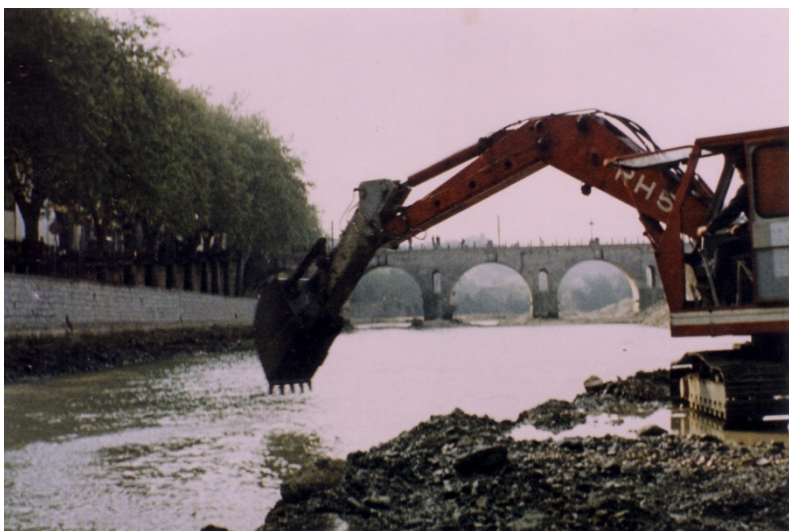
Travaux de curage – 1968 (Photo G. Vidal)
