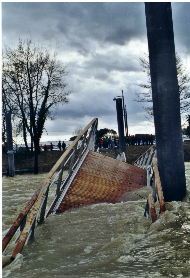
La passerelle emportée par les eaux – Mars 2001 (Photo G. Vidal)
