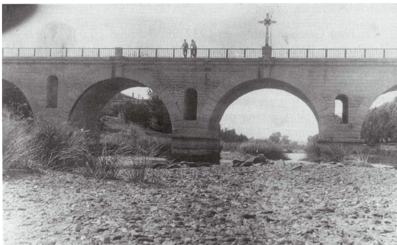
Bancs de graviers en aval du pont – 1938 (Photo R. Gaussen)
