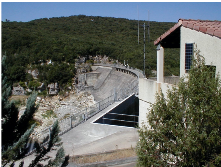
Barrage de la Rouvière à sec (Photo L. Boissier)
