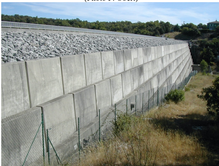
Barrage de Conqueyrac aval (Photo F. Obert)
