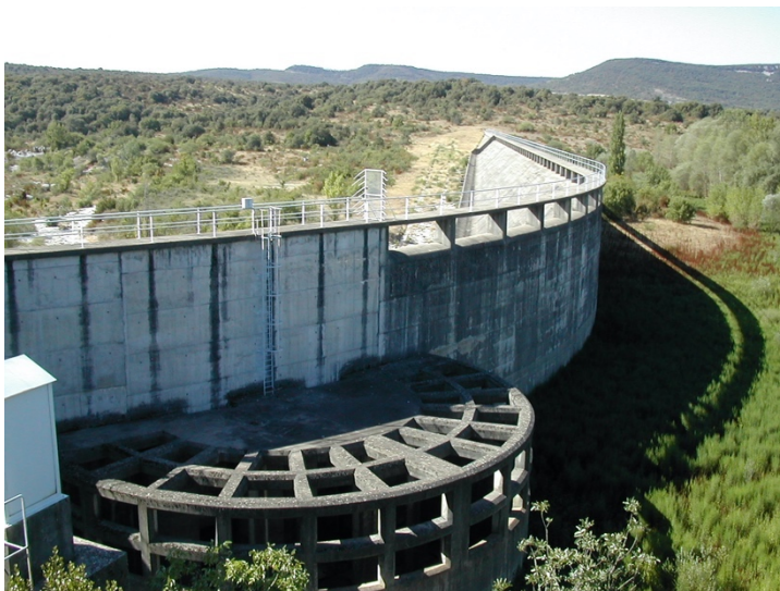
Barrage de Ceyrac amont (Photo F. Obert)
