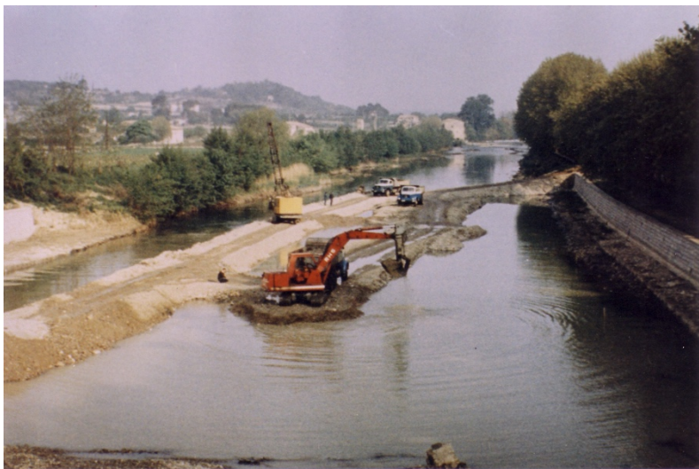
Travaux de curage – 1968 (Photo G. Vidal)
