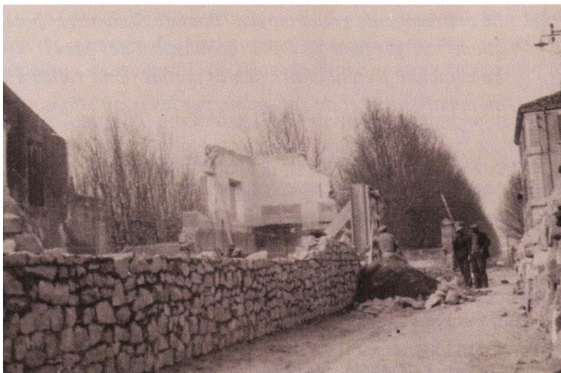
École de filles en construction après la crue – 1933 (Photo R. Gaussen)
