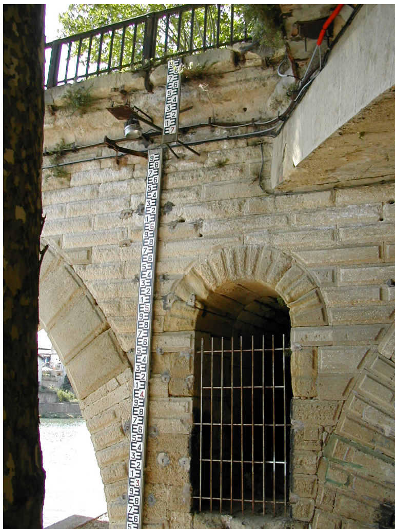
Echelle des crues – Rive gauche aval (Photo F. Obert)
