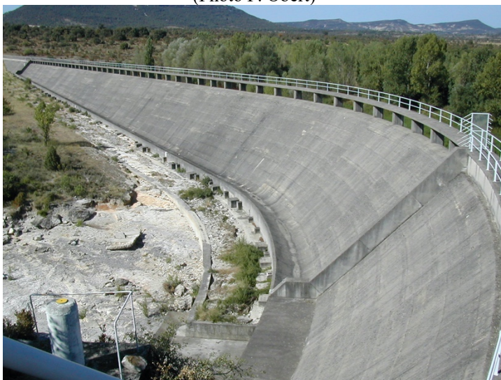
Barrage de Ceyrac aval (Photo F. Obert)
