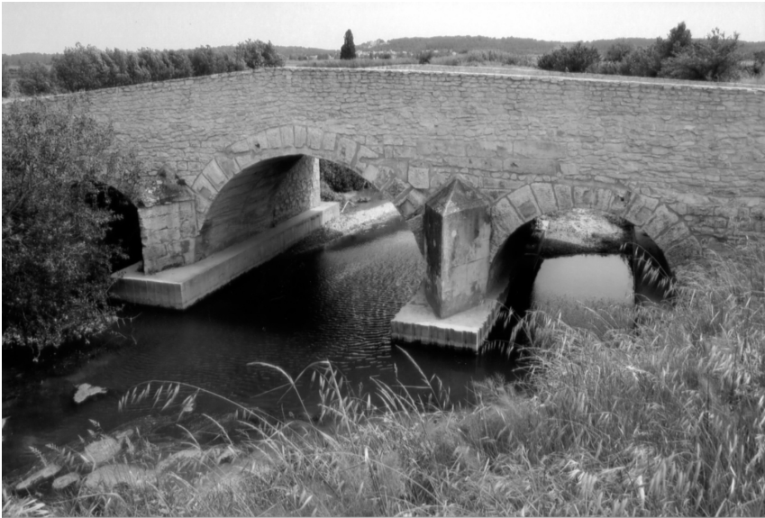
Pont de Nages Photographie A. Jeanjean
