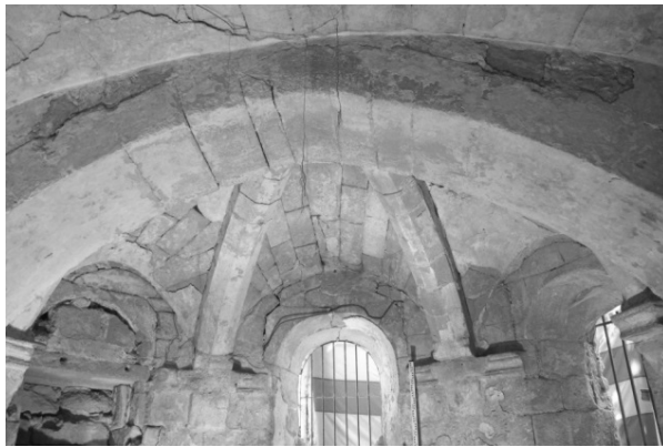
Figure 9 : abside de la chapelle avant travaux photographie N. Faucherre.
